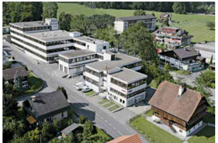
Leister Technologies AG, fabrika, Kaegiswil, Švajcarska
