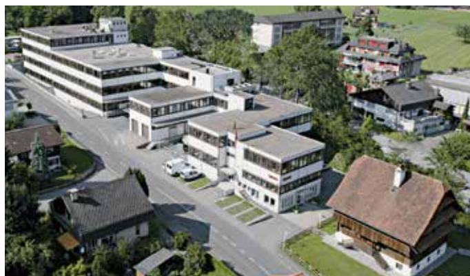
Leister Technologies AG, zgrada fabrike, Kaegiswil, Švajcarska
