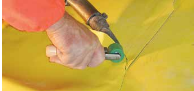
Jednoručni valjak predstavlja obaveznu opremupri izradi tunela
