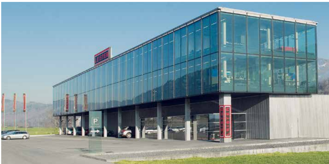
Leister Technologies AG, sedište kompanije, Kaegiswil, Švajcarska
