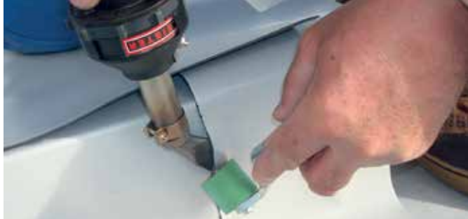
HOT JET S sa ugaonom diznom prilikom zavarivanja T spoja na krovu
