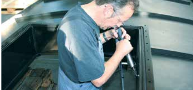
Zavarivanje PE kontejnera upotrebom DIODE PID.
