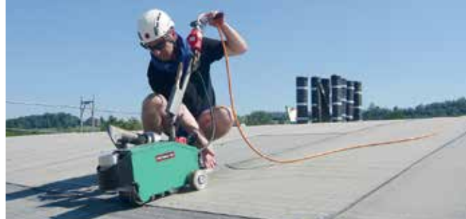
Zavarivanje modifikovanog bitumena korišćenjem BITUMAT B2.
