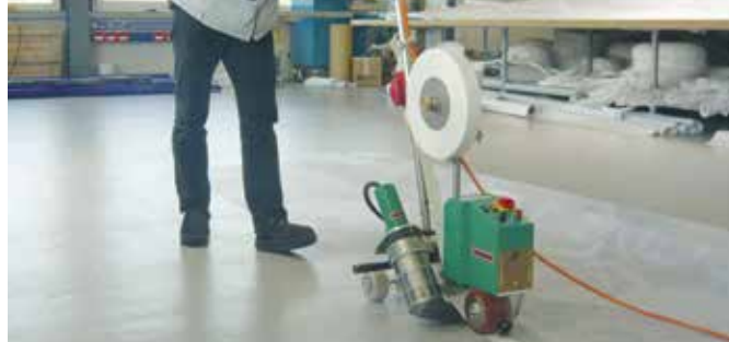
Zavarivanje trake maksimalnom brzinom.
